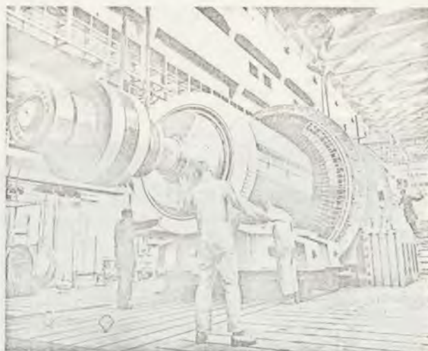
afb. 6 - Montage van een synchrone compensator 345 MVAR 2) (Foto ASEA).
