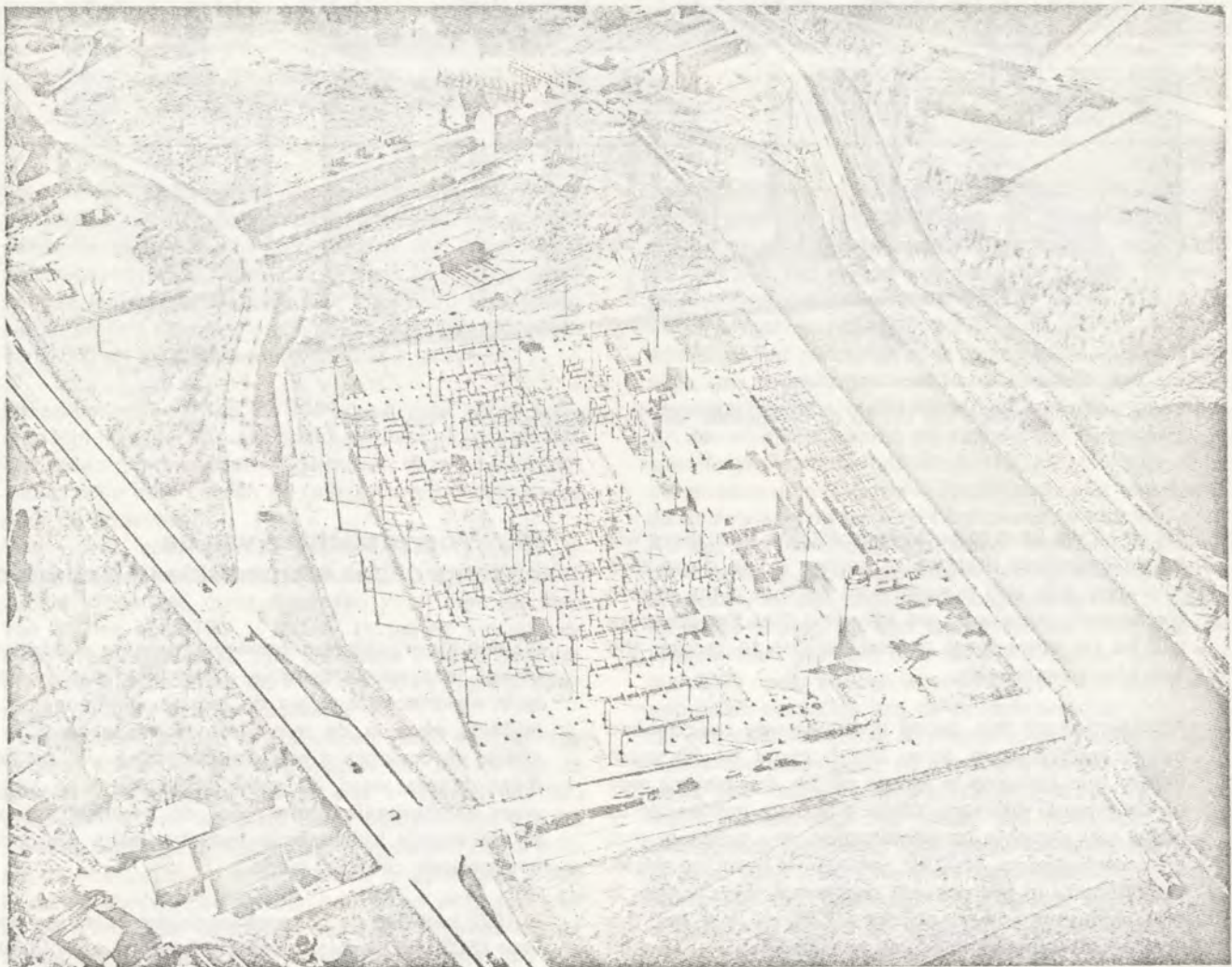
afb. 3 - 150 kV-station Gouda in open bouwwijze; bebouwde oppervlakte ca. 20.000 m 2 . (Foto E.Z.H.).
