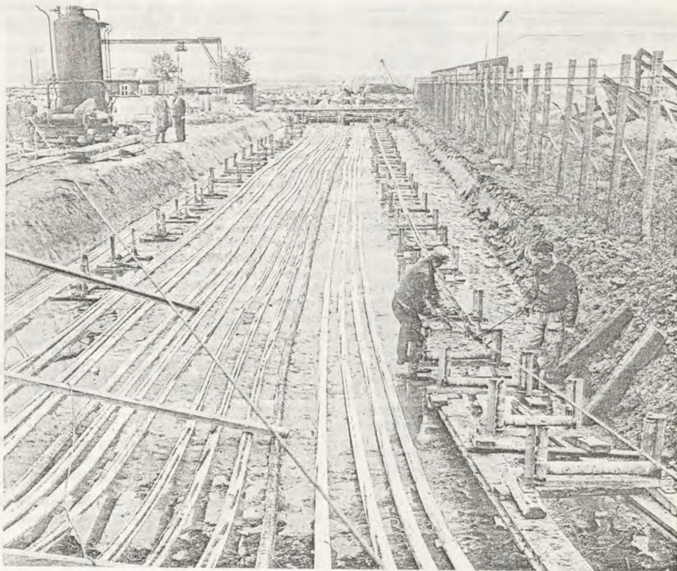
Het leggen van ondergrondse kabels. (Foto N.K.F.).
