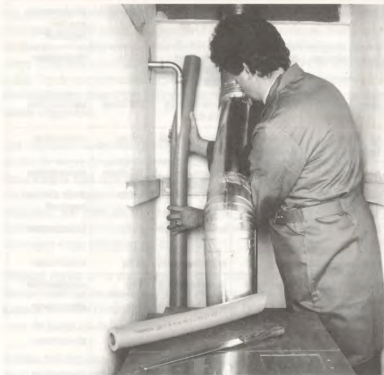
Fig. 16.5 Montage bij de klant
