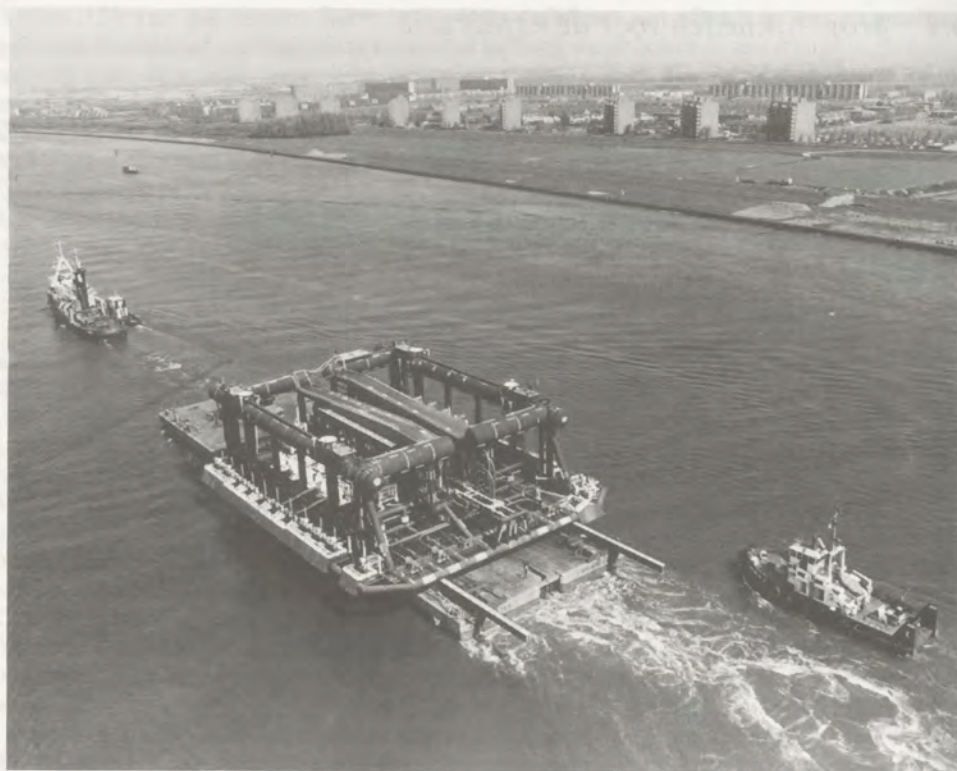
Het 'Underwater Manifold Centre' op weg naar het Cormorant veld. Bron: Shell Internationale Petroleum Maatschappij.
