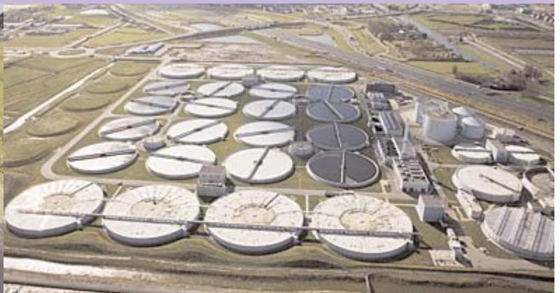
De waterzuiveringsinstallatie in de Harnaspolder, ten zuiden van Rijswijk, maakt gebruik van een biologisch proces. Het complex is tot stand gekomen als gevolg van een publiek-private samenwerking (PPS).
