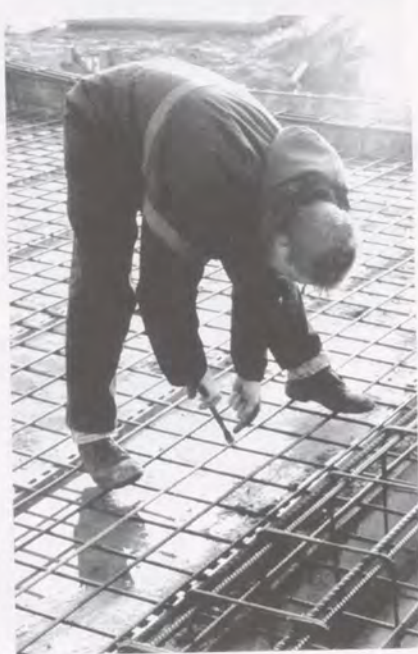
Fig. 8.10 Traditionele manier van binden waarbij de betonstaalverwerker diep voorovergebogen moet staan
