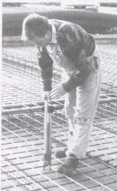
Fig. 8.11 Een betonstaalverwerker met de Drillfix
