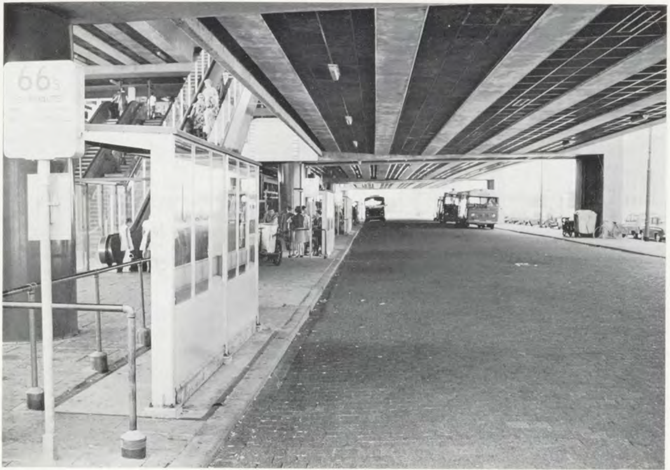
Afb. 2. Metrostation Rotterdam-Zuidplein. Een fraai voorbeeld van een goede overgangsprocedure.
