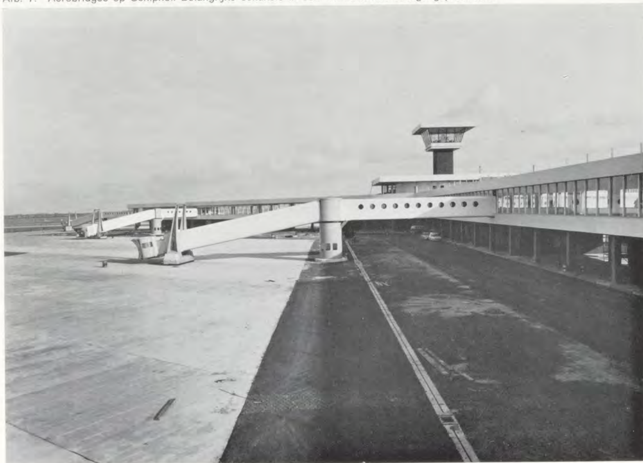
Afb. 7. Aerobridges op Schiphol. Belangrijke schakels in een comfortabele overgangsprocedure.
