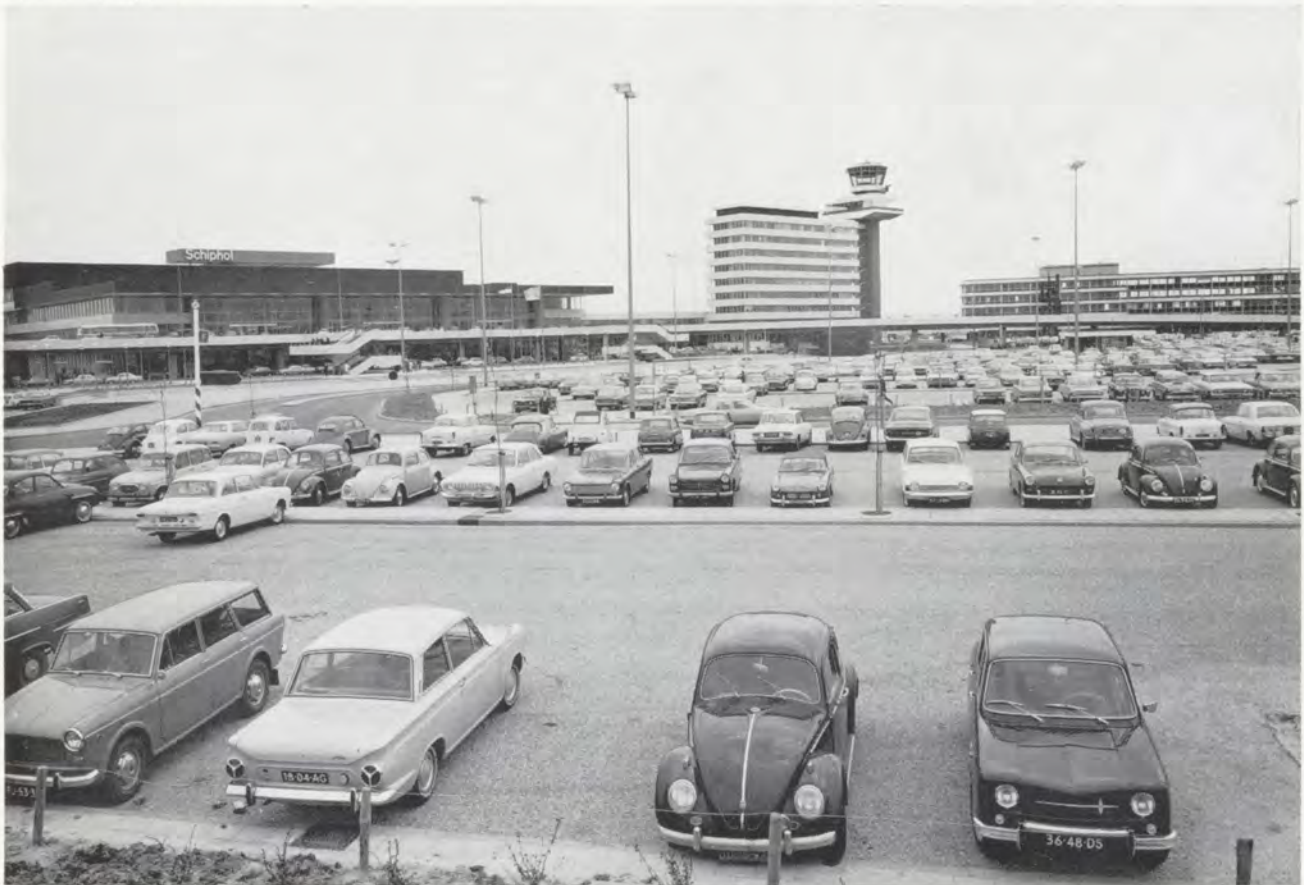
Afb. 6. Stationsgebouw Schiphol. Goede voorrijdmogelijkheden voor bussen, taxi's en particuliere auto's. Parkeergelegenheid op korte (loop)afstand.
