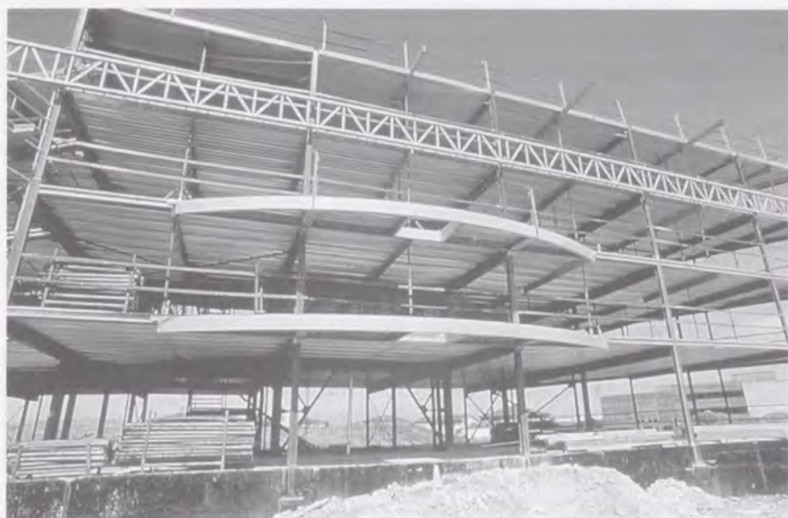
Fig. 3.19 Frans voorbeeld: stalen kolommen, stalen liggers, staalplaatbetonvloeren voor woningen in La Rochelle
