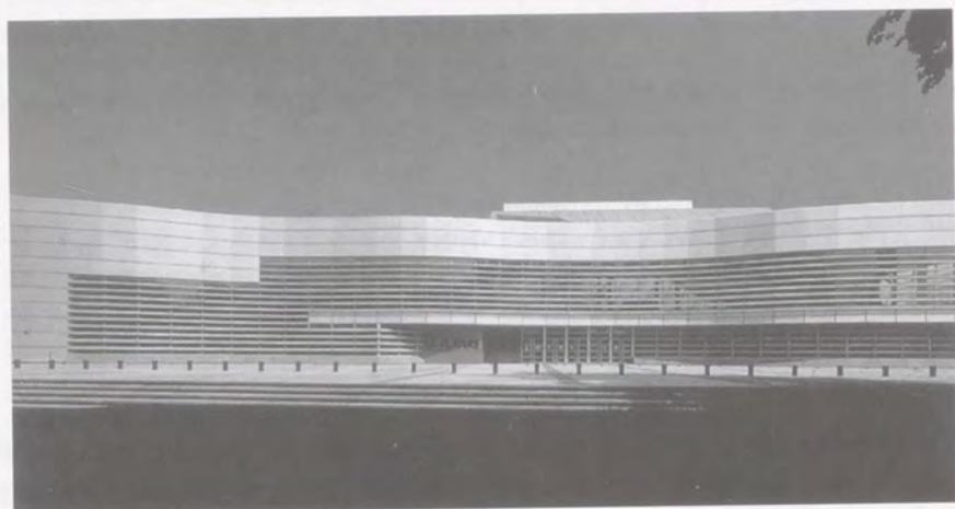
Fig. 3.36 Vasconi: Koudespouwfaçade met vaste zonweringsstrook (Centre Culturel de Mulhouse, Frankrijk) Bron: [Renckens, 1996]
