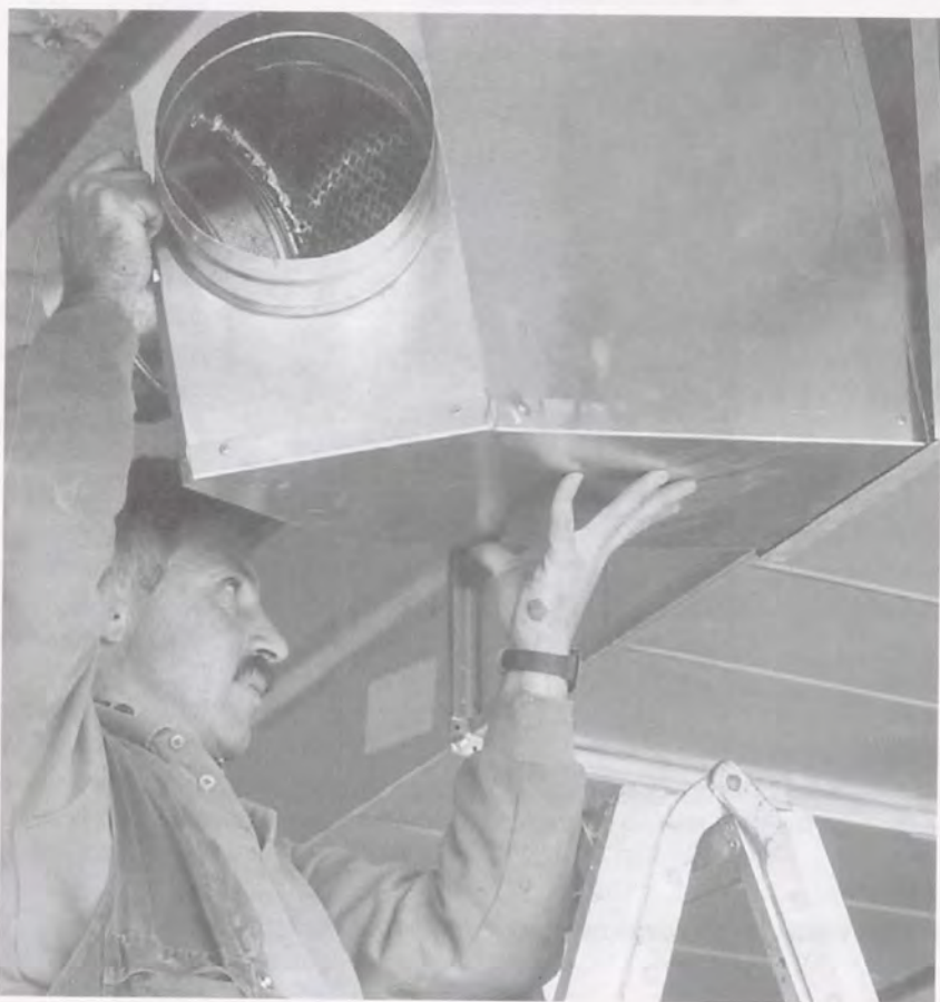
Fig. 3.31 Inklikken van een afgiftemodule in het luchtdistributiekanaal
