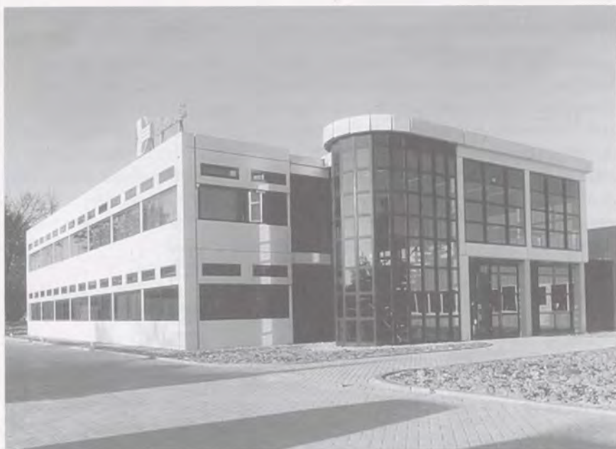
Fig. 4.3 Kantoorgebouw in het Unideksysteem in Heerlen
