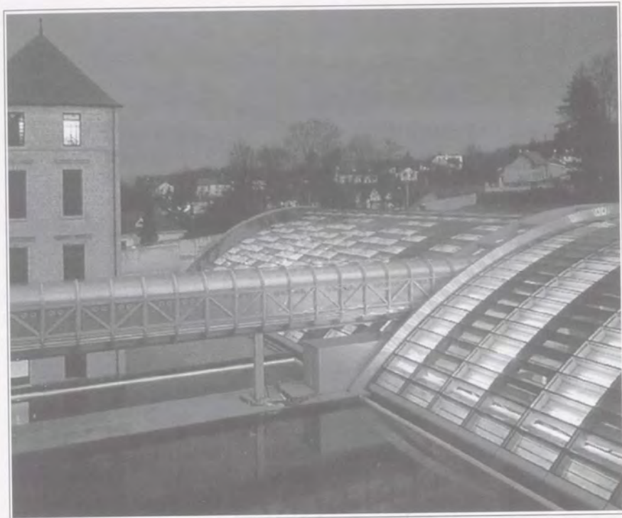
Fig. 3.35 Perrault: Gebogen aluminiumglasfaçade met beweegbare zonreguleringschoepen (Hotel Departemental, Bar-le-Duc, Frankrijk) Bron: [Renckens, 1996]
