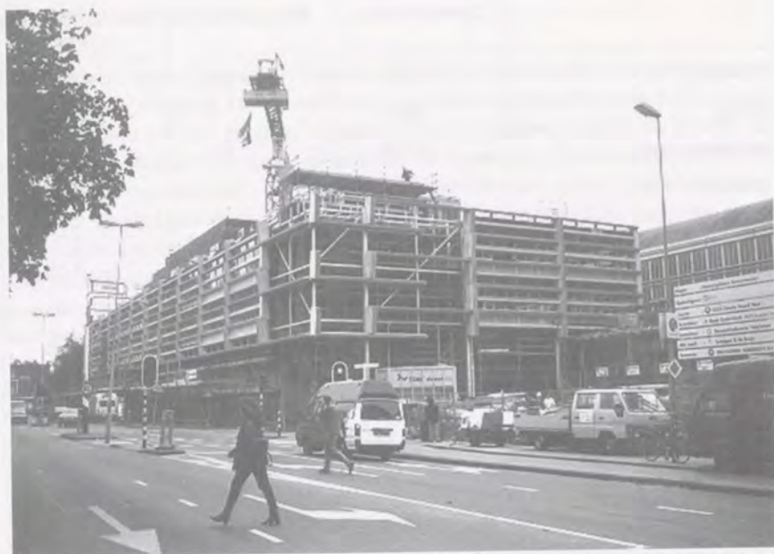
Fig. 4.1 Kantoorgebouw aan het Kennemerplein in Haarlem in aanbouw (oktober 1996) Bron: J. Vonk, Haarlem
