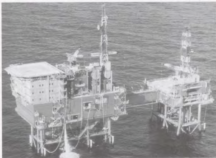
Fig. 7.32 Offshore jacket Bron: Staalbouwkundig Instituut
